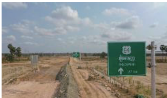
Fig. 17 Project Construction Site
