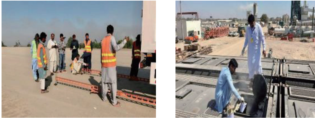
Fig. 14 PKM Construction Site
