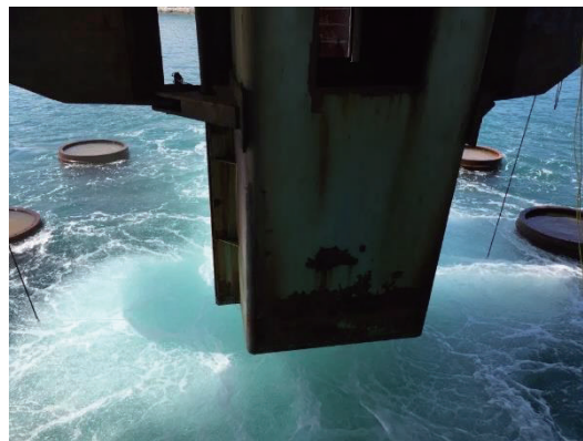
Fig. 49 Actual effect of bubble curtain
